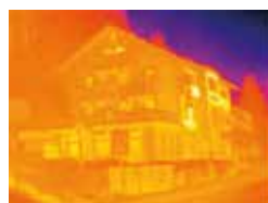
Wärmebild ohne testo ScaleAssist
