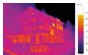
Wärmebild mit testo ScaleAssist
