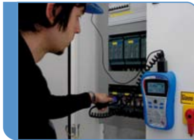
Prüfen der Impedanz an der Schaltschränken.
