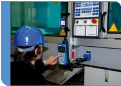
Prüfung der Impedanz und der RCD-Einrichtung an elektrischen Anlagen.
