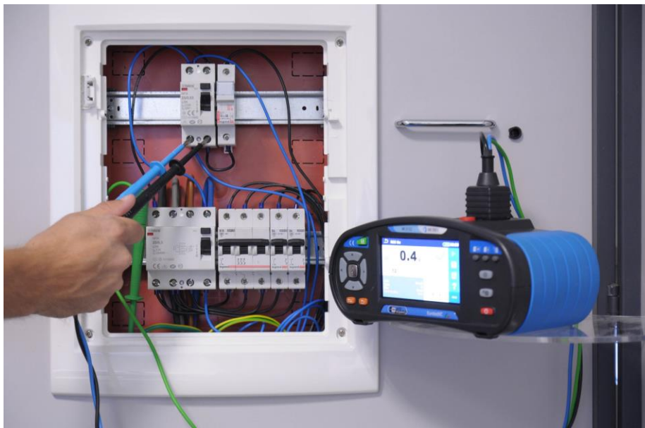
Abbildung 2-24: RCD Messung im Verteiler des Application Trainers mit Kabeln auf der Versorgungsseite
