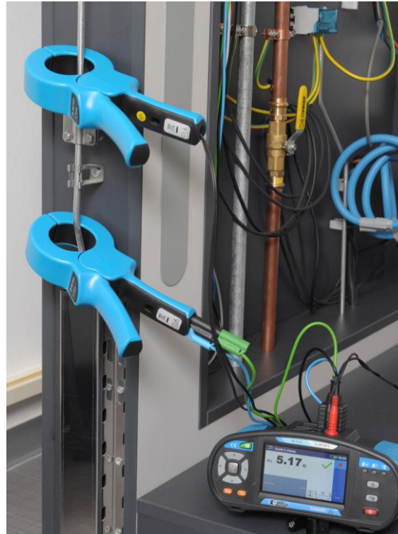
Abbildung 2-50: Prüfung der Blitzschutzanlage
