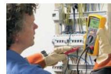
Isolationsprüfung an einer Unterverteilung
