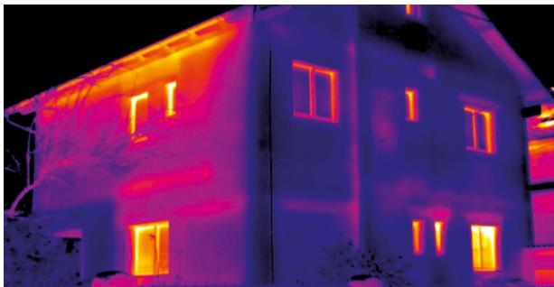
Gebäudeanalyse: Wärmeverluste, Baufeuchte und Schimmel aufspüren.
