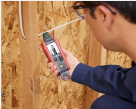
Suche von spannungsführenden und spannungsfreien Adern/Leitungen
