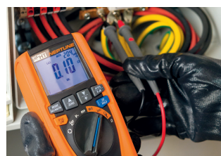
Durchgangsprüfung von Schutzleitern.
